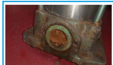
Incrostazioni presenti nel collettore di una motore pompa – Inefficienza e conseguente blocco
