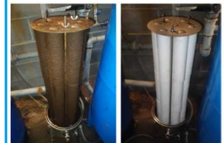
Elemento di Prefiltrazione dopo tre mesi - Elemento Filtrante a nuovo
